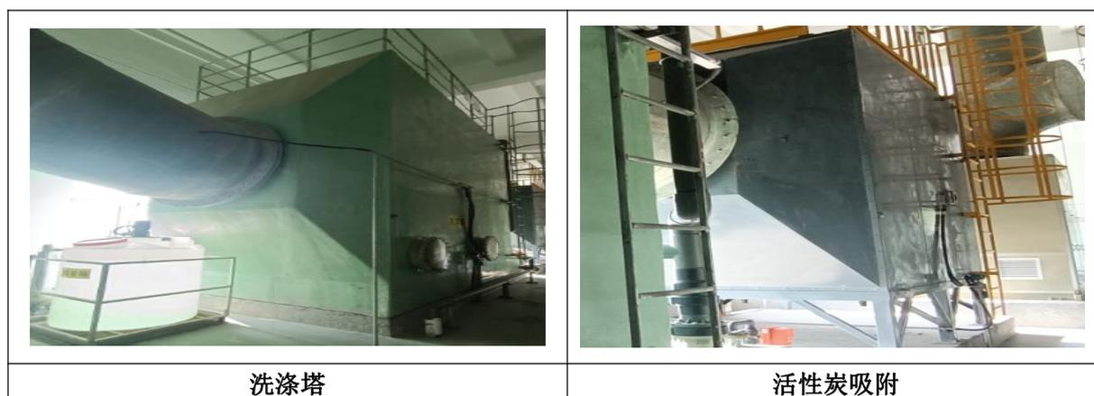
图 2.1-9 物化车间废气处理设施
