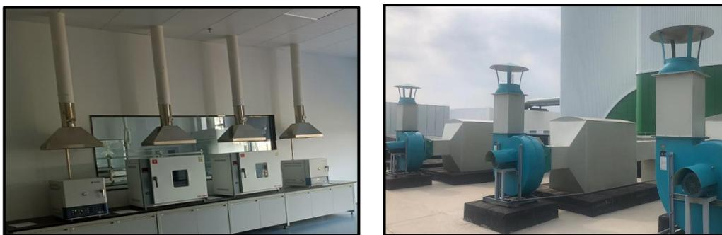
图 2.1-12 实验室废气处理设施
